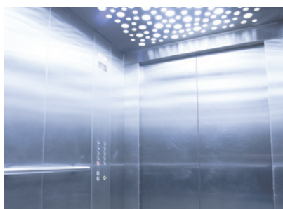
Montaż panelu sterowania do ścian windy.
